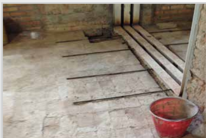
Rinforzamento sismico
